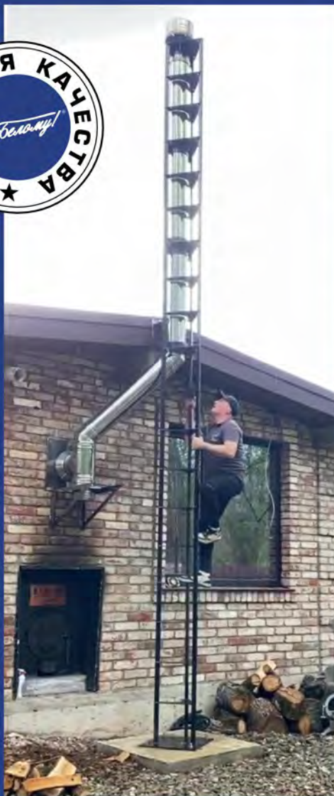
Лестница для монтажа и обслуживания дымохода и доступа на крышу
